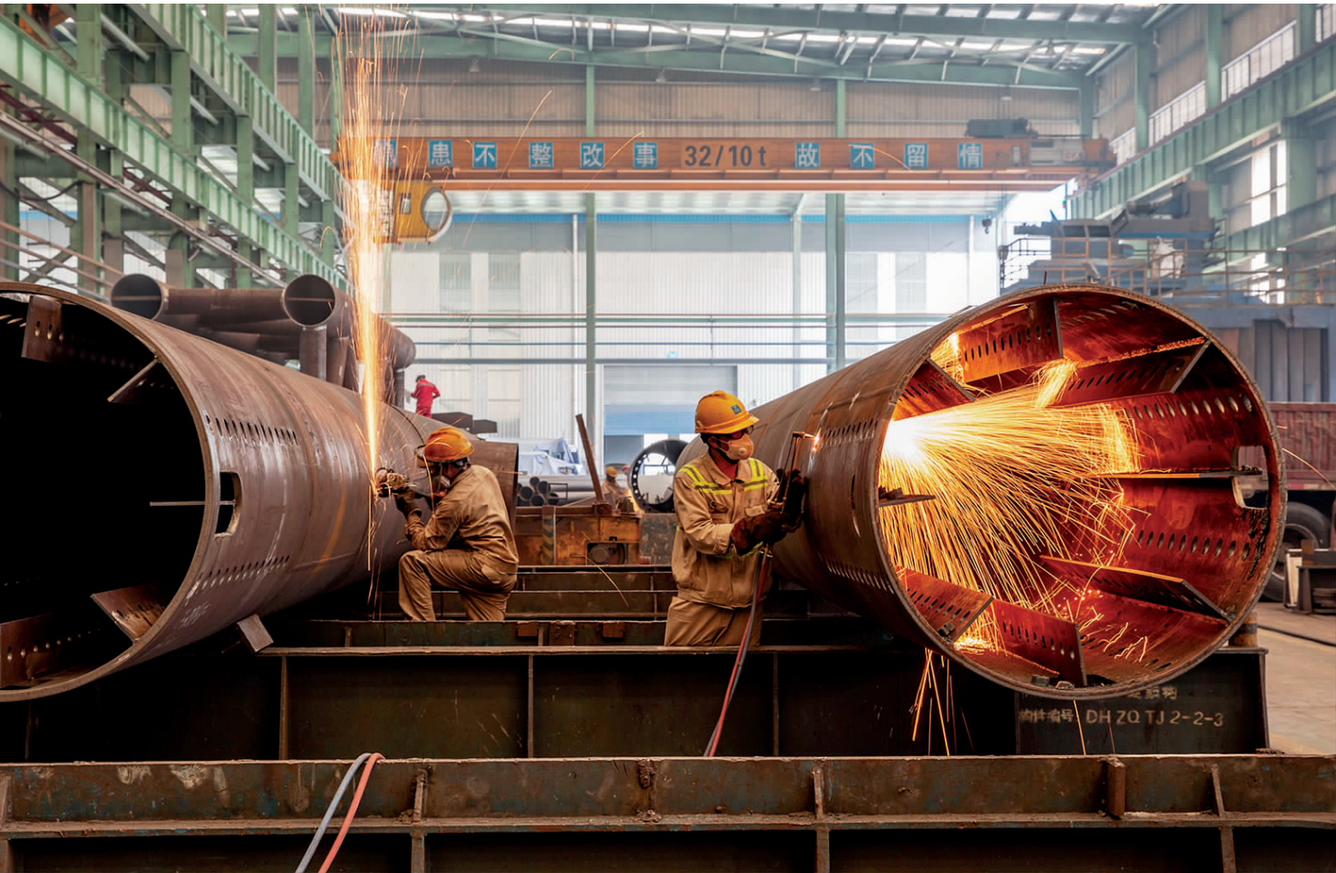
眉山天府新区中建钢构生产车间,工人们在岗位上忙碌工作。 眉山融媒记者 向哲 摄
