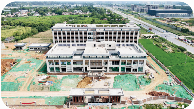
建设中的彭山区第三人民医院。
