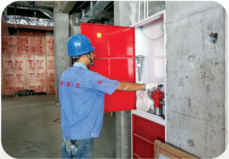
工人在检查消防装置。
