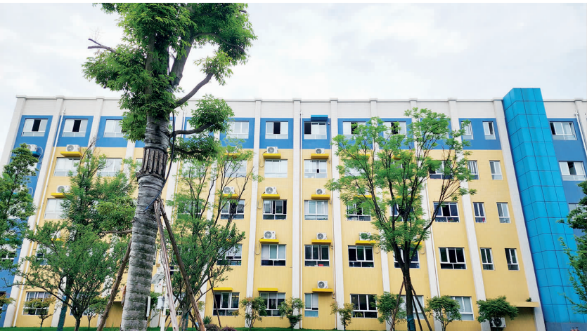
新安装的空调。
