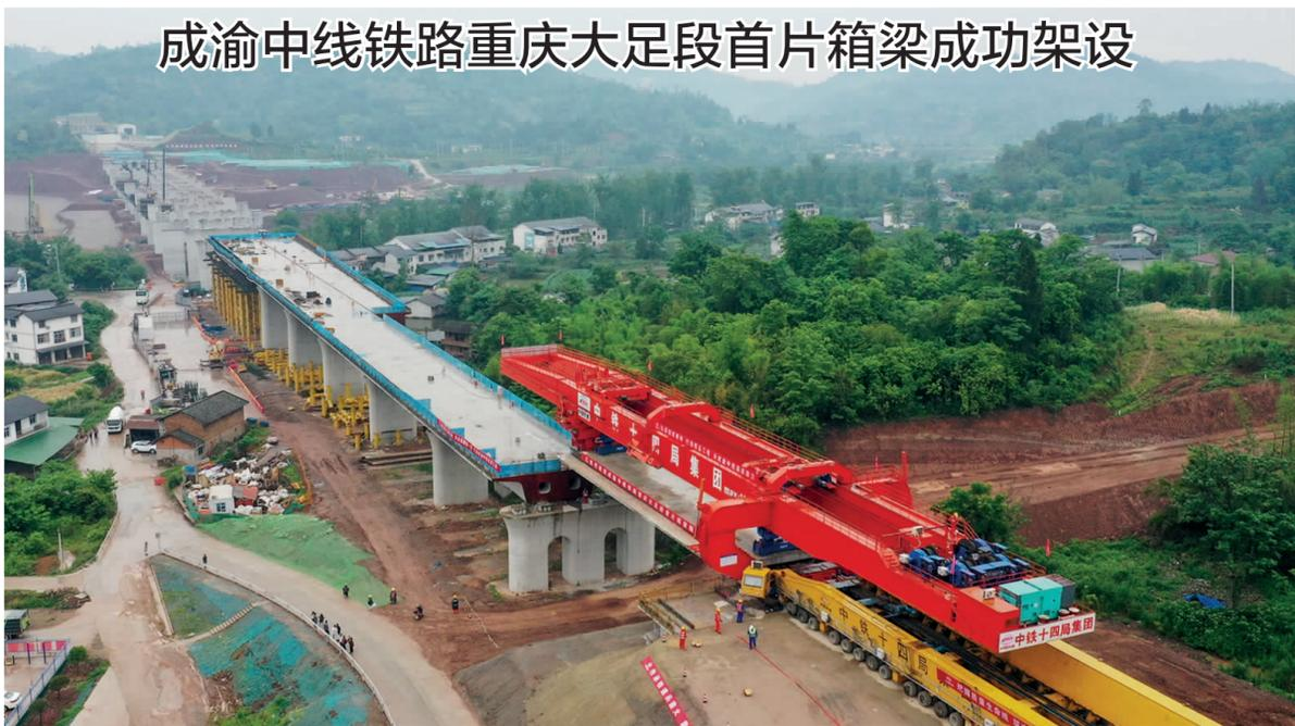
5月16日，成渝中线铁路重庆大足段大足石刻站四线道岔特大桥梁首片双联箱梁进入安装阶段(无人机照片)。
