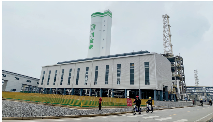
川金象年产30万吨氰胺材料全产业链项目生产区域。
