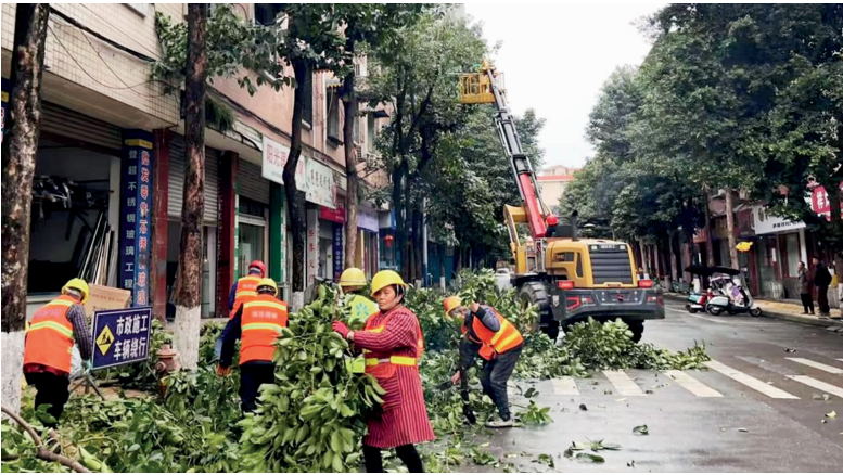
工人正在清理树木，为地下管道施工做准备。
