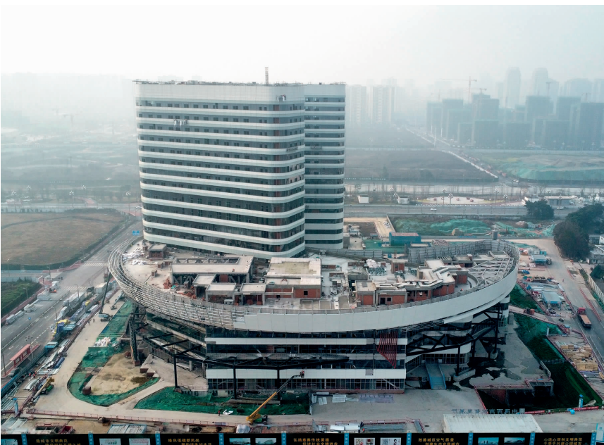
项目建设现场。
