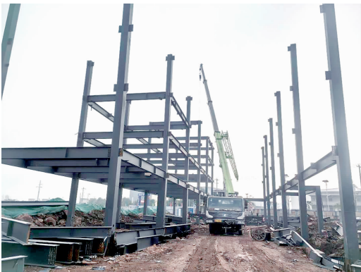
年配套2万吨航天装备产品生产项目正在进行钢结构施工。
