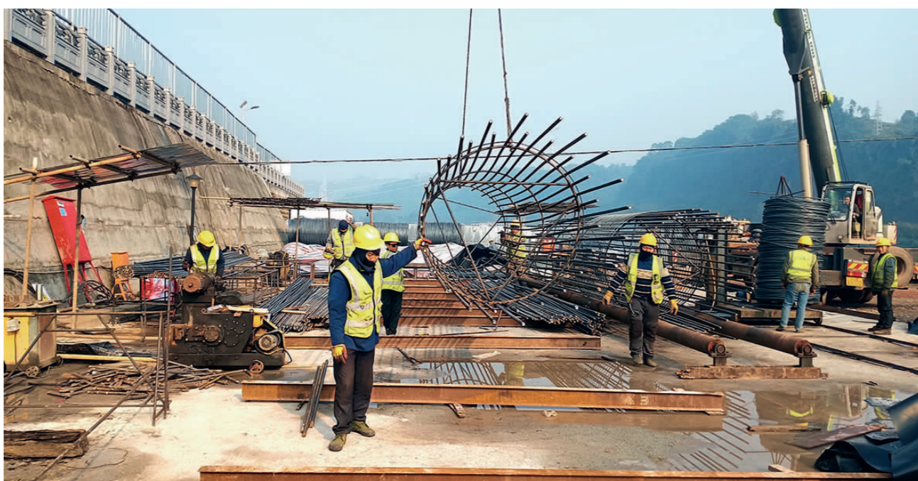
罗坝大桥改造项目有序推进。
