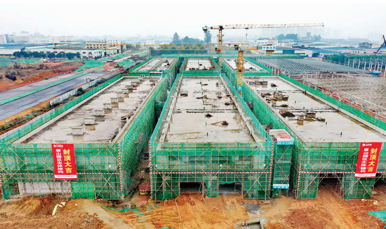
项目主体结构封顶。
