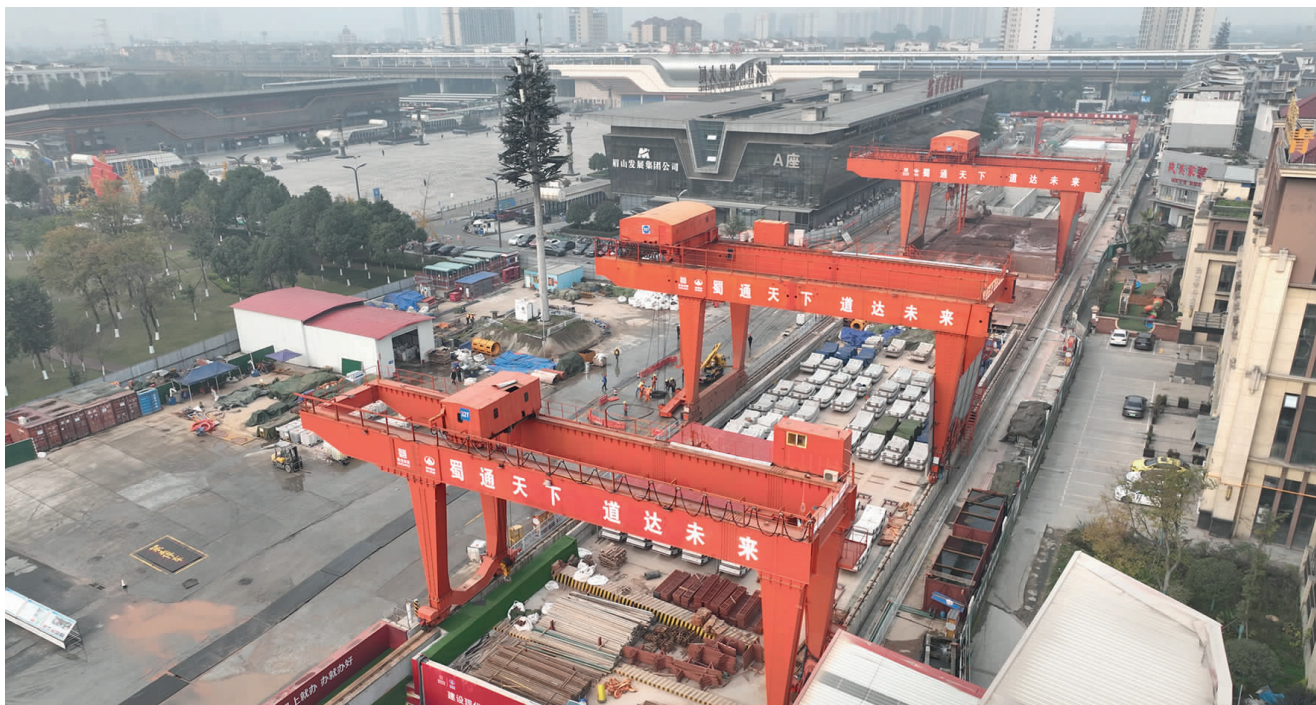
日前，成眉市域铁路S5线眉山东站主体结构顺利封顶。 眉山融媒记者 雷同 摄
