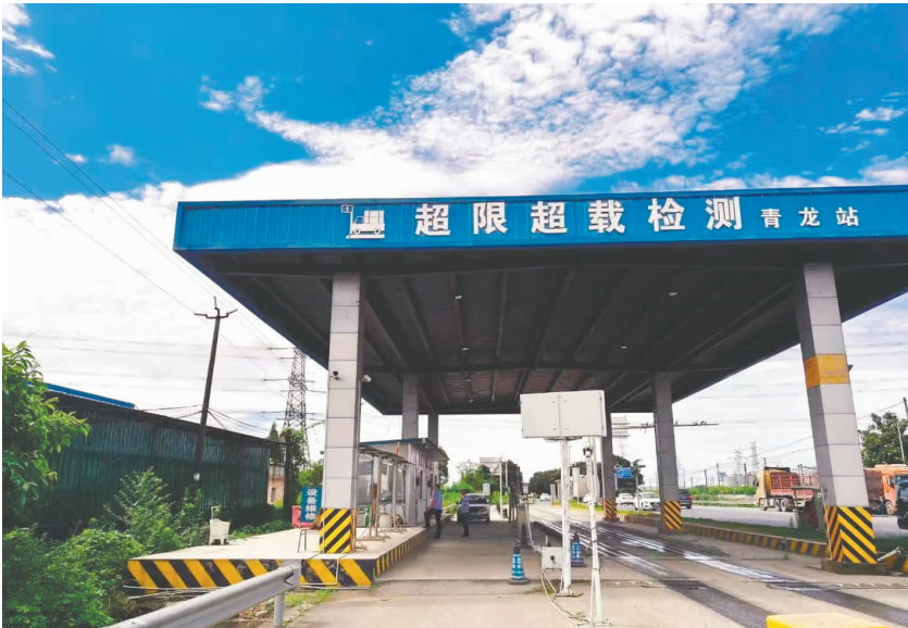
改造后的超限超载检测青龙站。
