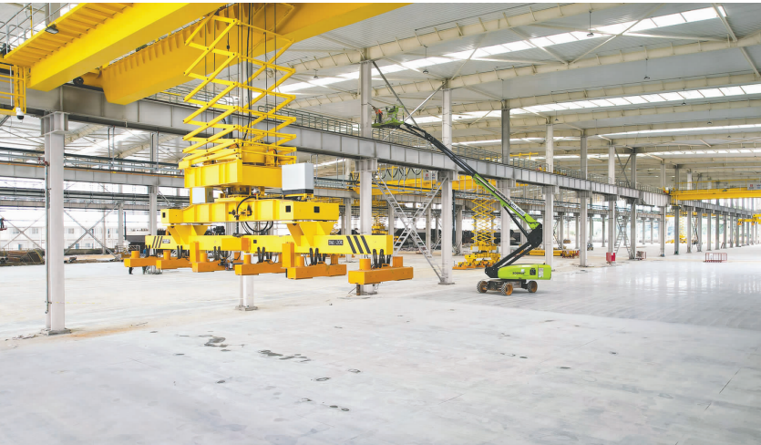
建成投用的四川省钢构智造有限公司“无人化”智能料库。
