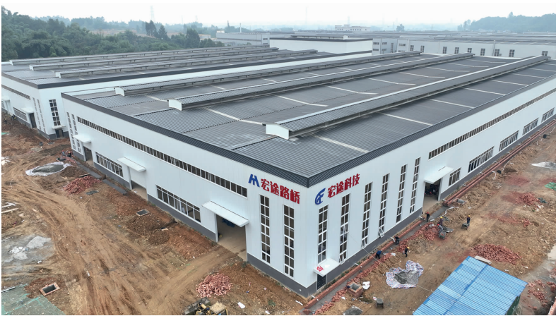
宏途路桥桥梁核心连接构件制造项目主体工程基本完工。
