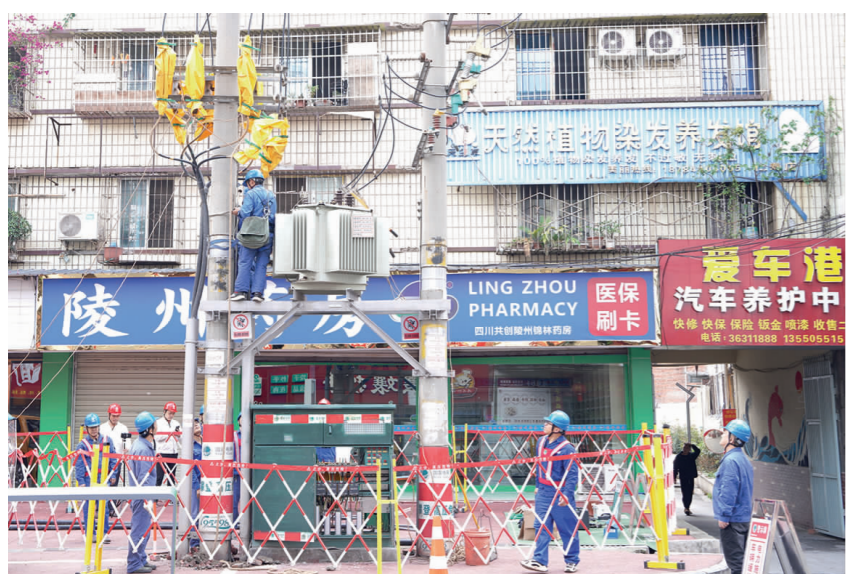
配电变压器出线升级改造施工现场。
