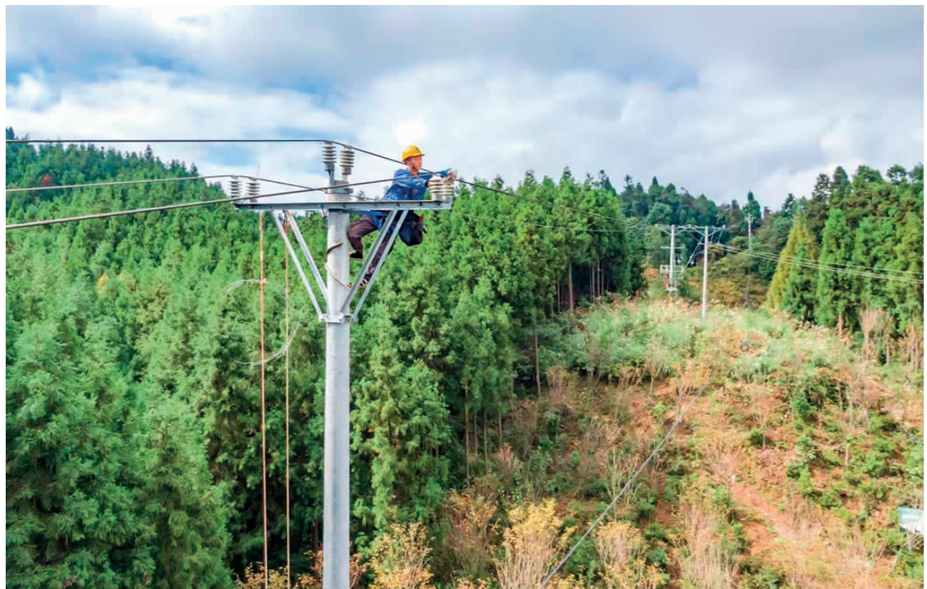
在10千伏柳晏线玉屏山支线增补电杆1基，解决森林防火隐患。 王鸿飞 摄
