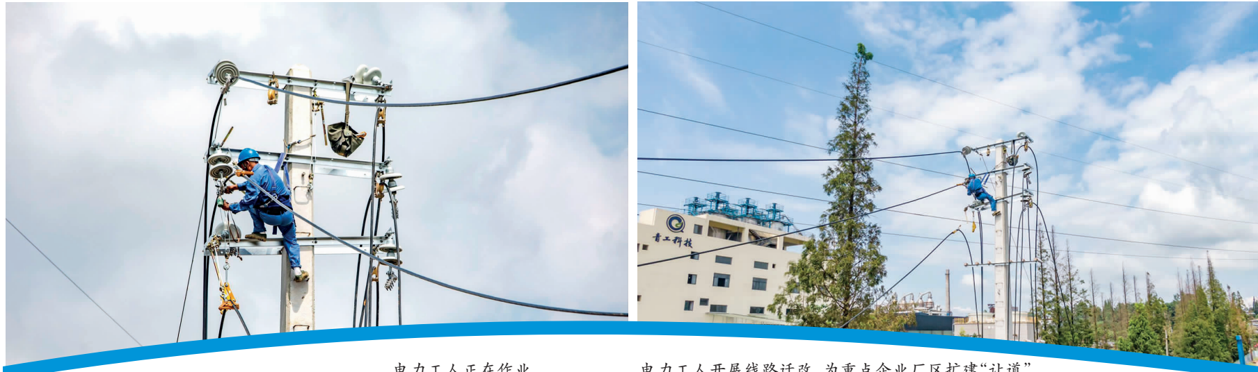
电力工人正在作业。
