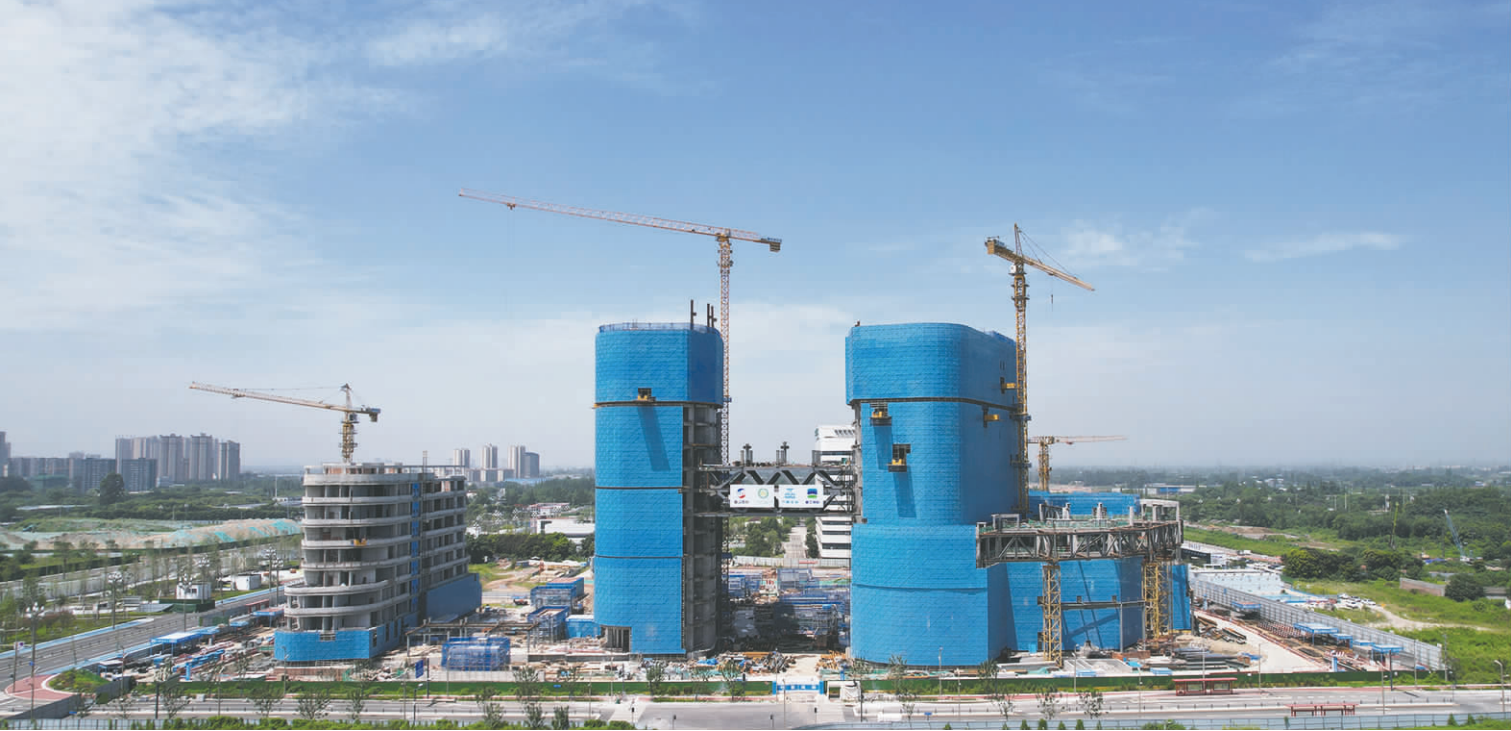
四川大学华西第二医院天府医院(四川省儿童医院)二期项目建设顺利推进。
