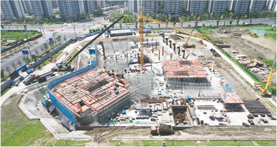
眉山市工人文化宫项目顺利推进，预计年底完成主体施工。
