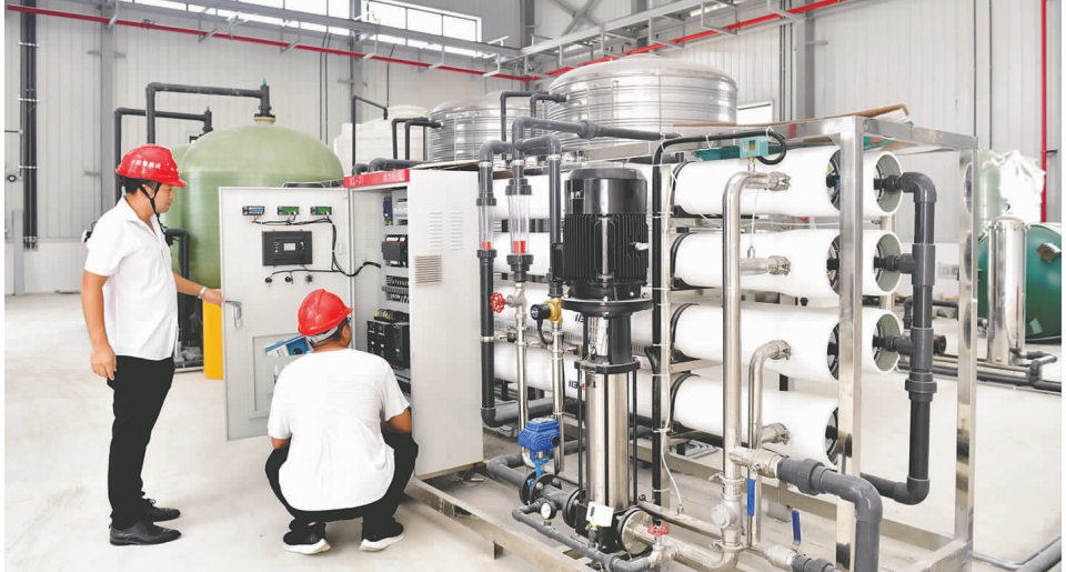
眉山市新能源新材料融合创新中心全面建成，工人正在进行投用前的准备工作。
