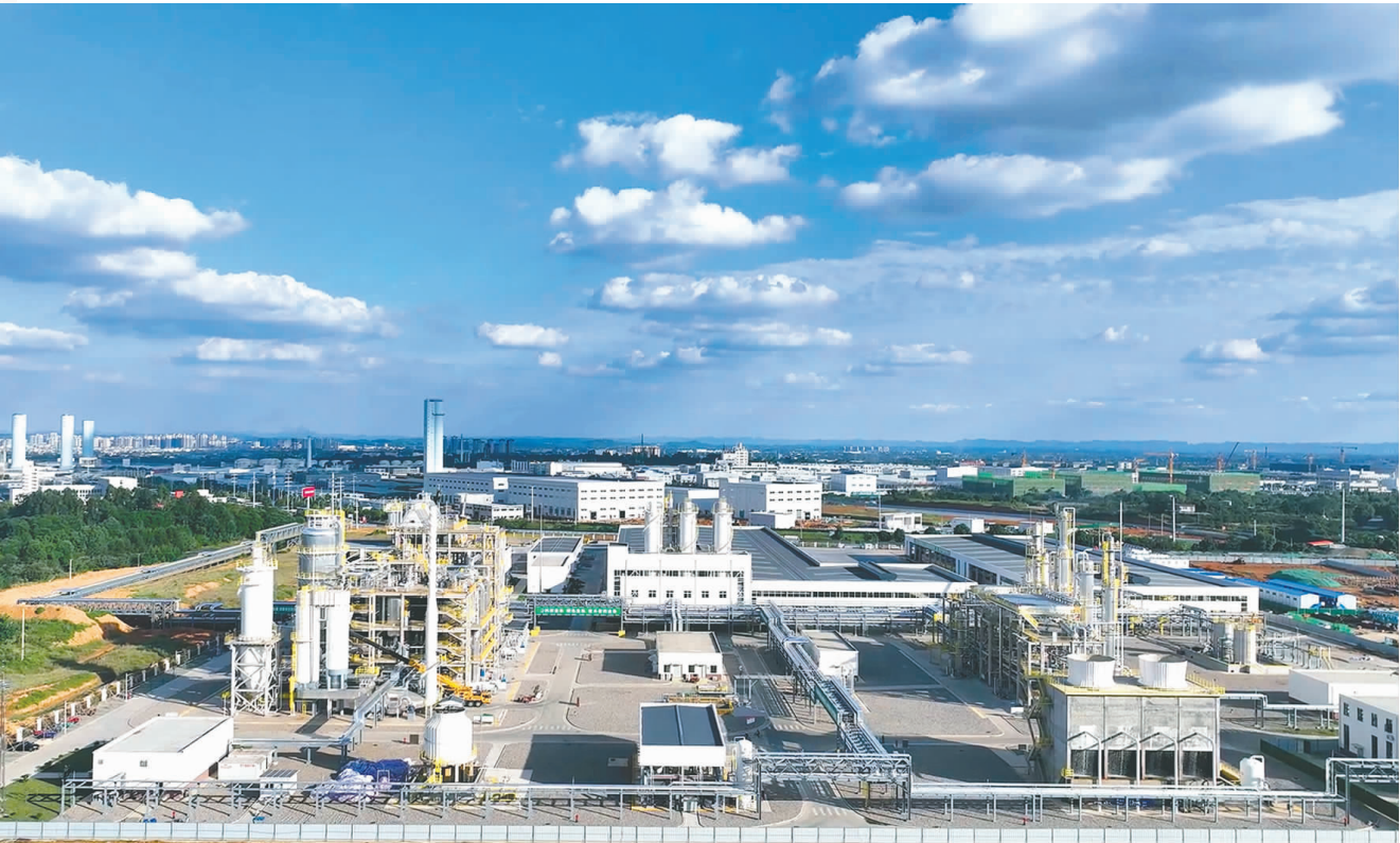
川金象年产30万吨脲胺及碳氮新材料一体化项目正在加紧建设。
