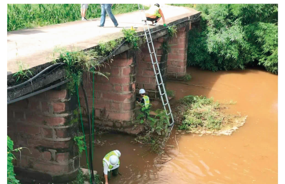
桥梁安全性能检测现场。
