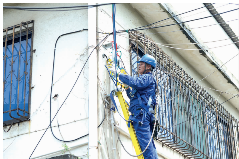
工作人员在更换导线。吴华羽 摄
