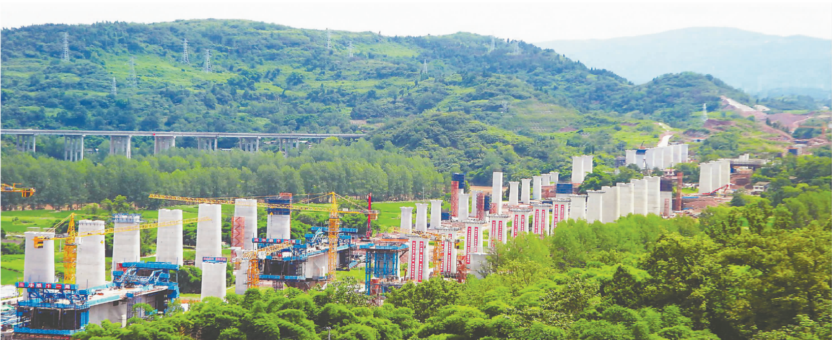
7月16日,达州高新区石板街道红花村,成达万高速铁路铜钵河特大桥建设现场。
