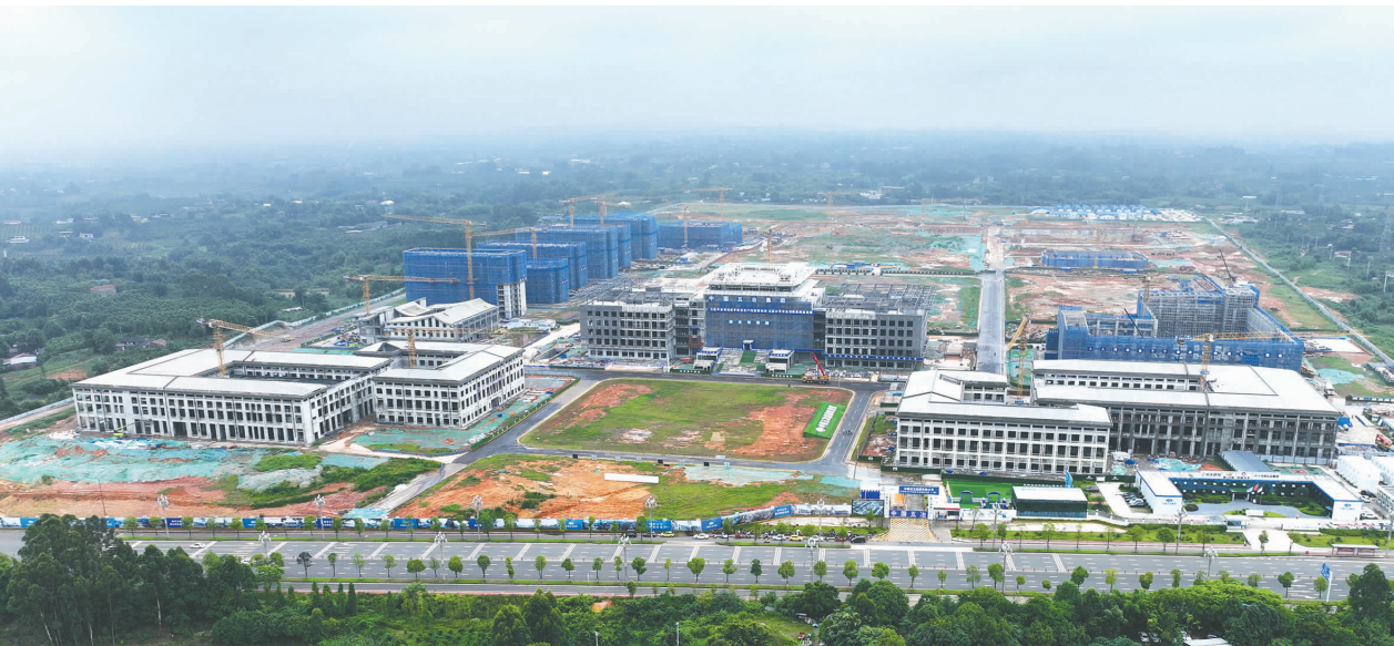
7月15日,建设中的四川大学眉山校区项目。眉山日报全媒体记者 雷同 摄
