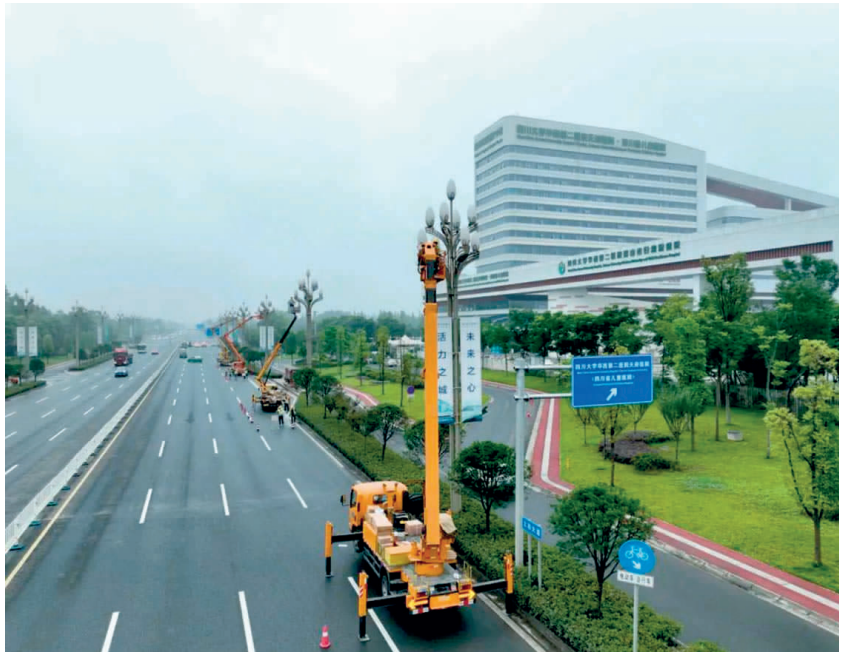
工人在进行路灯更换。
