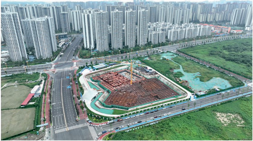
项目施工现场。
