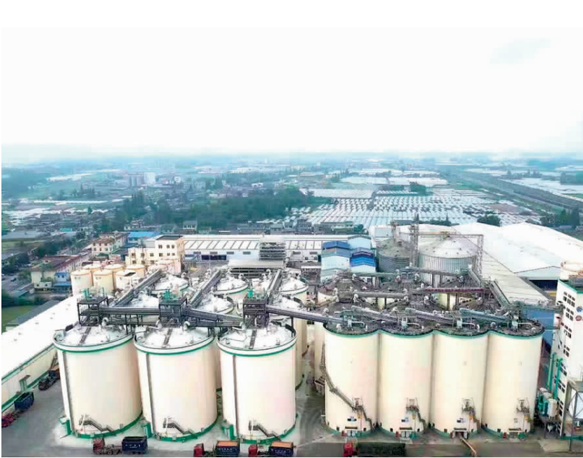
彭山区10万吨仓储设施。
