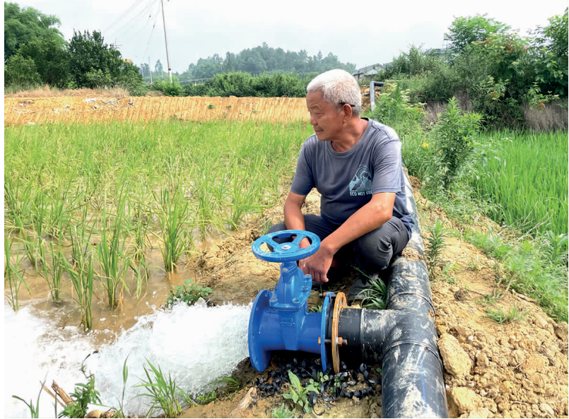
高台镇“渠改管”试点。
