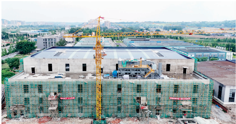
技改升级项目主体工程建设已完成,进入内部装修及设备安装调试阶段。
