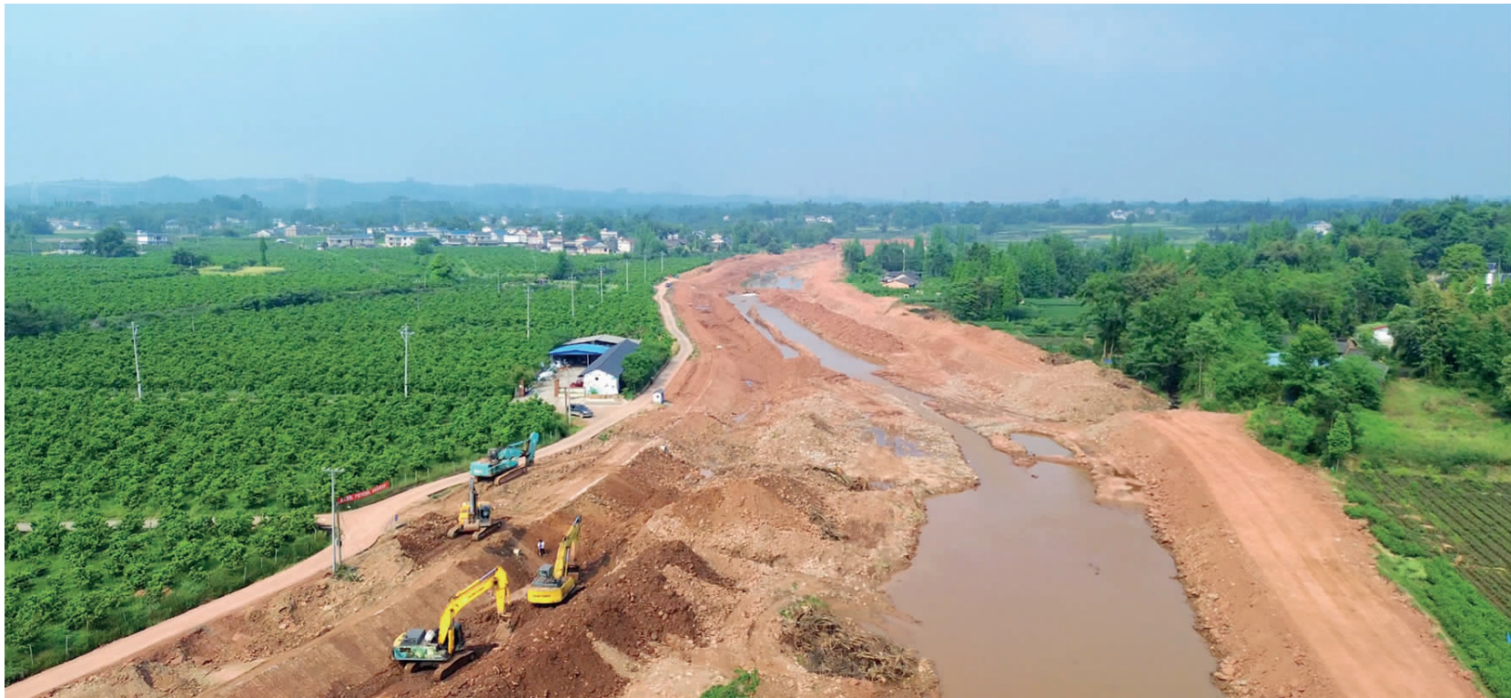
正在建设中的安溪河余坪镇防洪治理工程。
