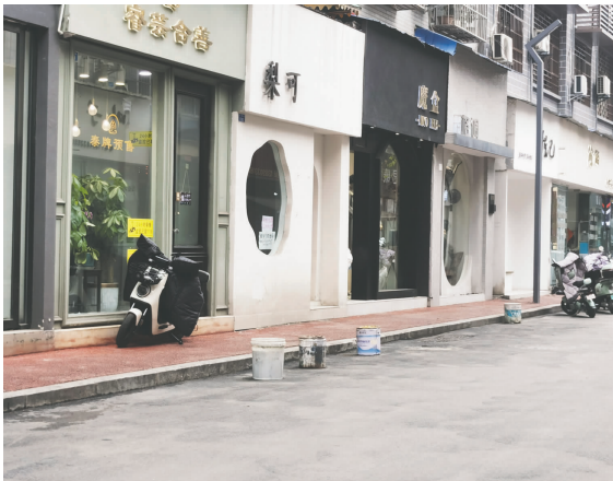
下午3点50分,东坡区兴隆街133号附近,商家私自设置障碍物占用公共道路。
