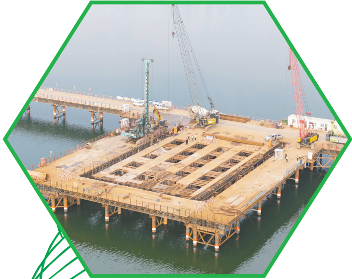
青神汉阳岷江特大桥施工现场热火朝天。
