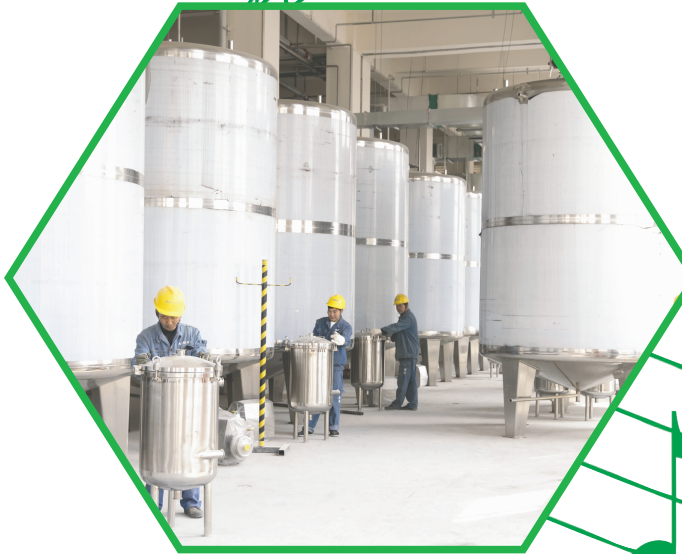
彩虹健康产业园内正在进行设备安装。
