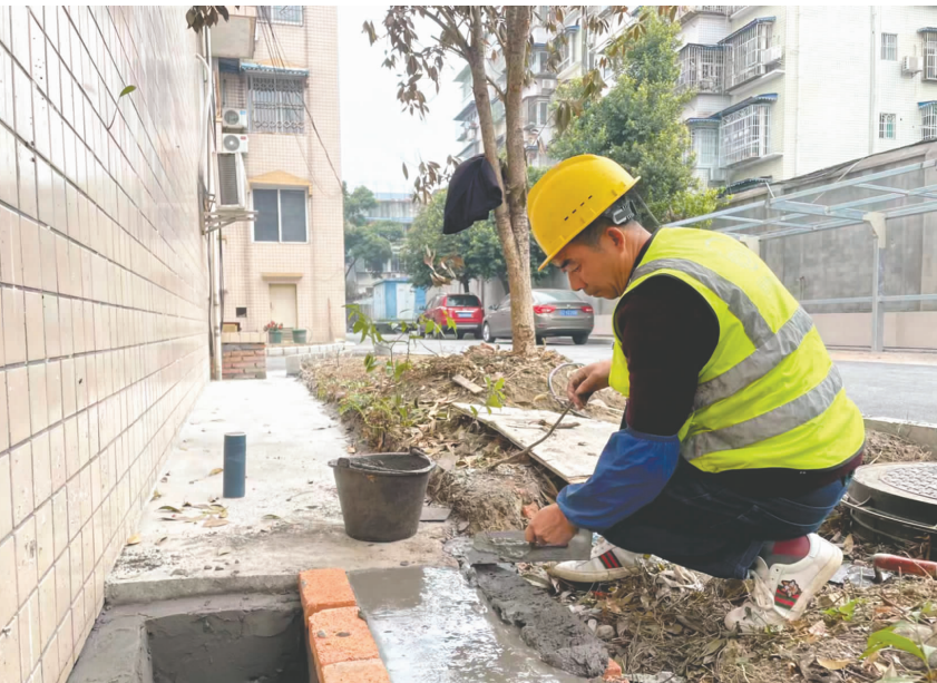
老旧小区改造现场。
