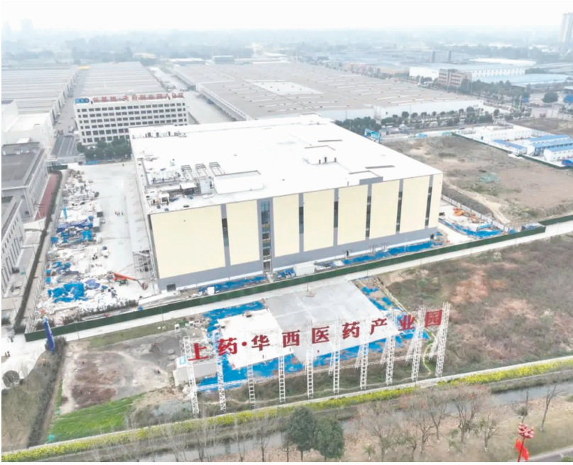
上药华西眉山物流中心一期项目建设现场。
