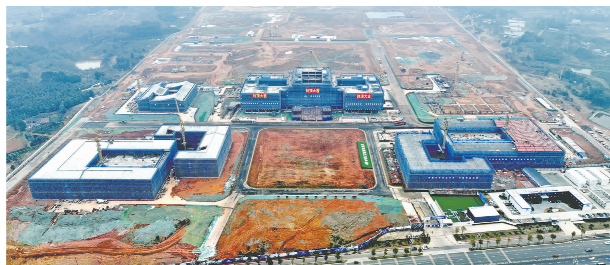
正在建设中的四川大学眉山校区。
