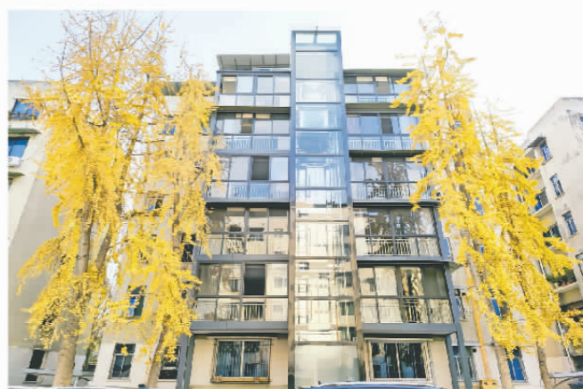
老旧小区增设电梯。
