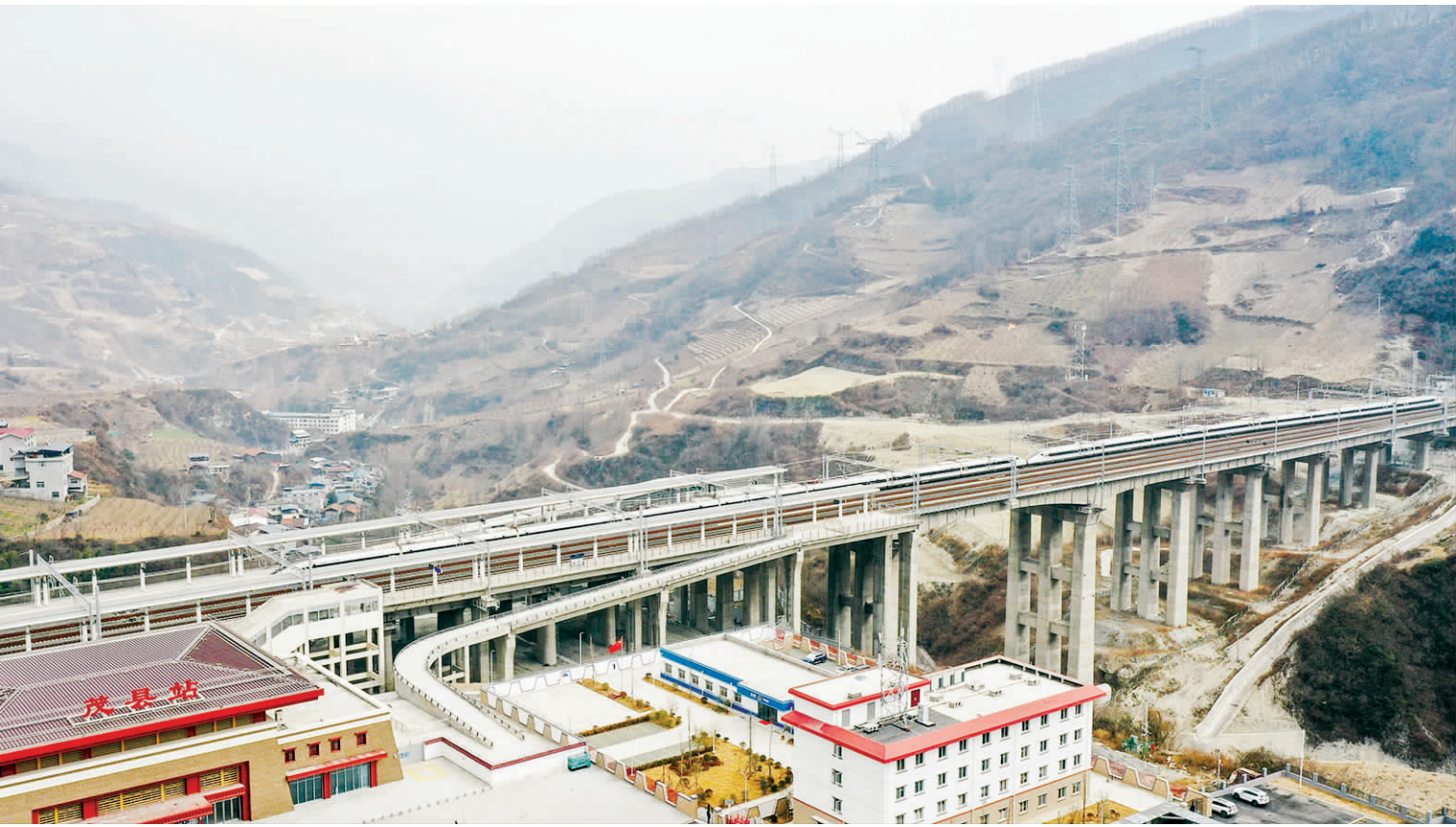
1月28日，一列动车组驶出川青铁路茂县站(无人机照片)。
