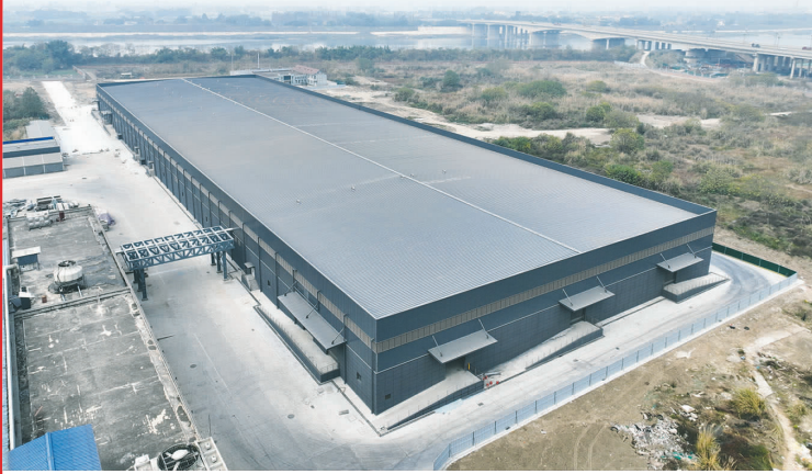
二期项目正在加紧建设。
