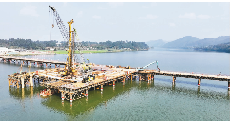
天眉乐高速汉阳岷江特大桥施工现场。
