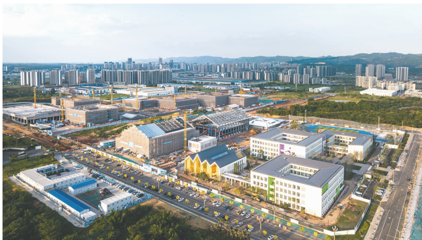
眉山天府学校建设有序推进中。
