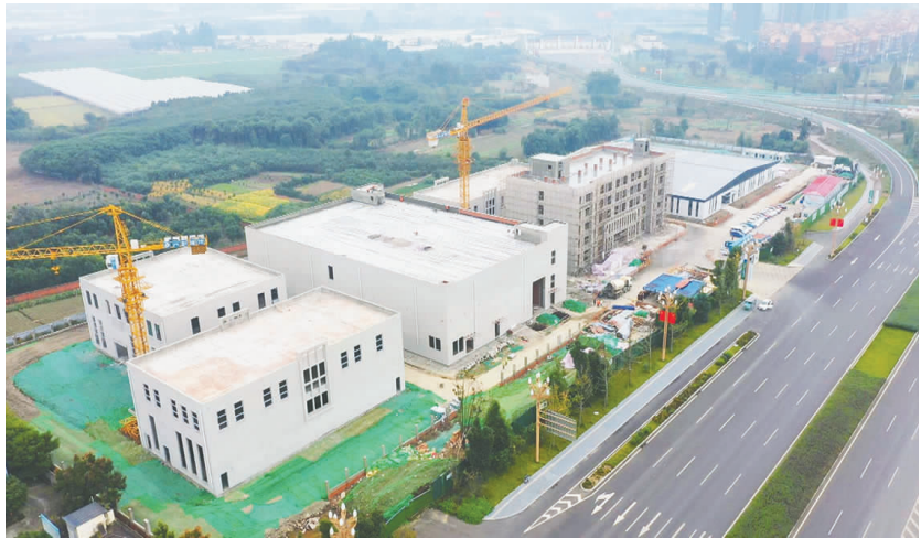
航拍彭山区农副产品冷链仓储配送基地项目。
