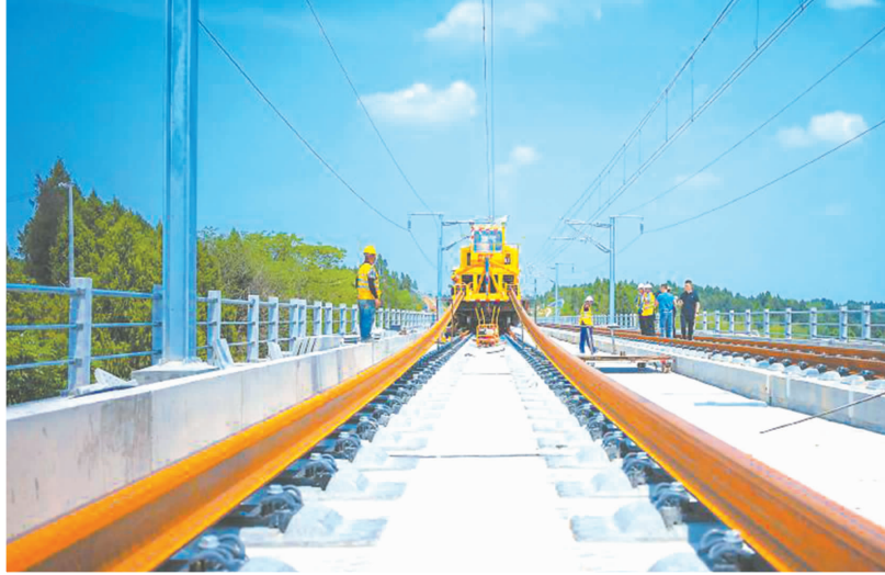
成宜高铁全线铺轨完成。图据《四川日报》
