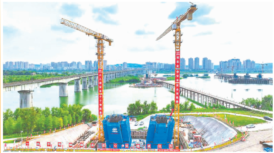
位于遂宁市的成达万高铁涪江特大桥施工现场,工人们正在抓紧施工建设。 图据《四川日报》
