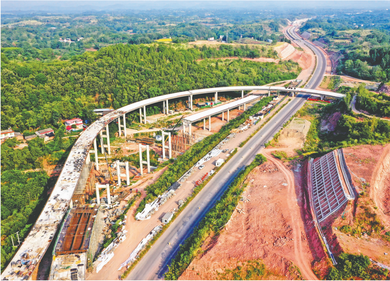
梓州大道南延线项目建设正有序推进。
