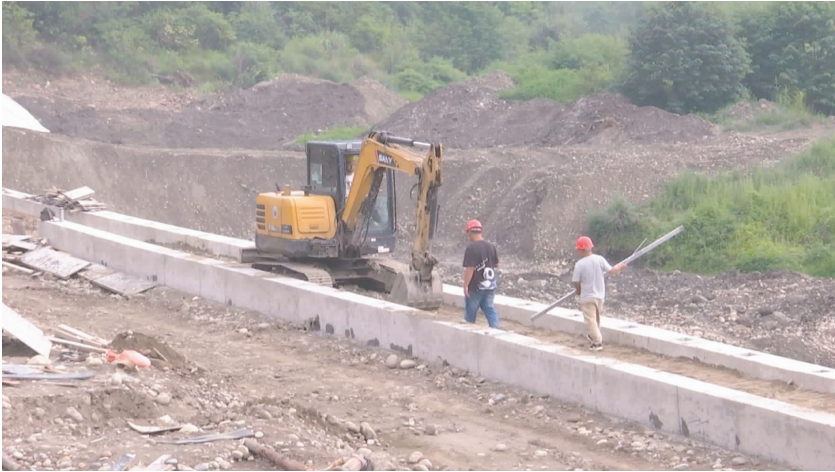
堤坝建设现场。
