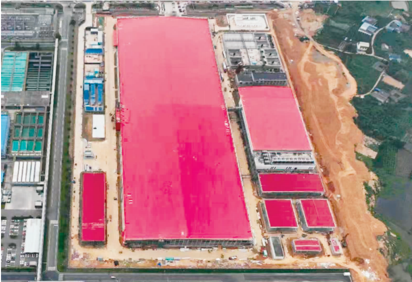
四川美科年产32GW单晶硅切片项目一期建设现场。
