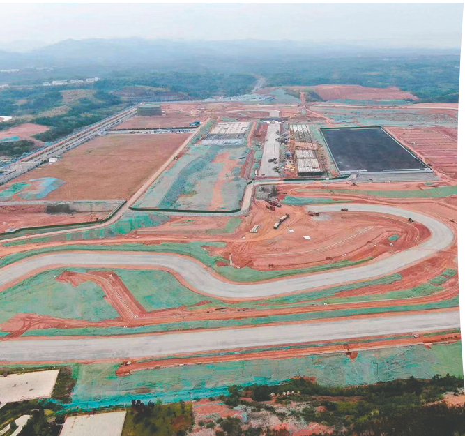
成都天府国际赛道正抓紧施工。
