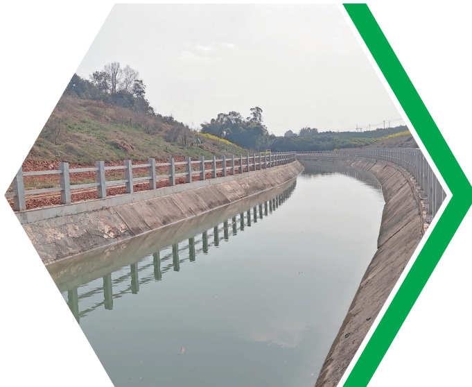
东风支渠(原土地乡境内)。
