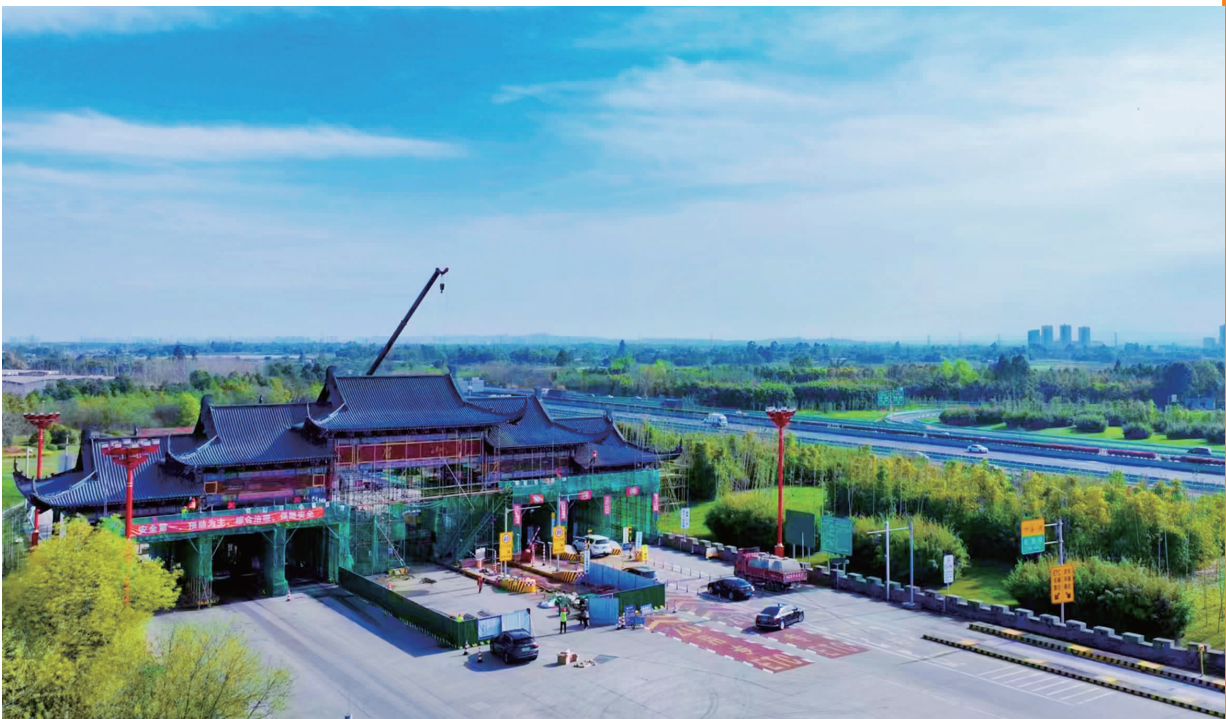
成乐高速眉山收费站4座匝道收费棚修缮加固工程已基本完工。
