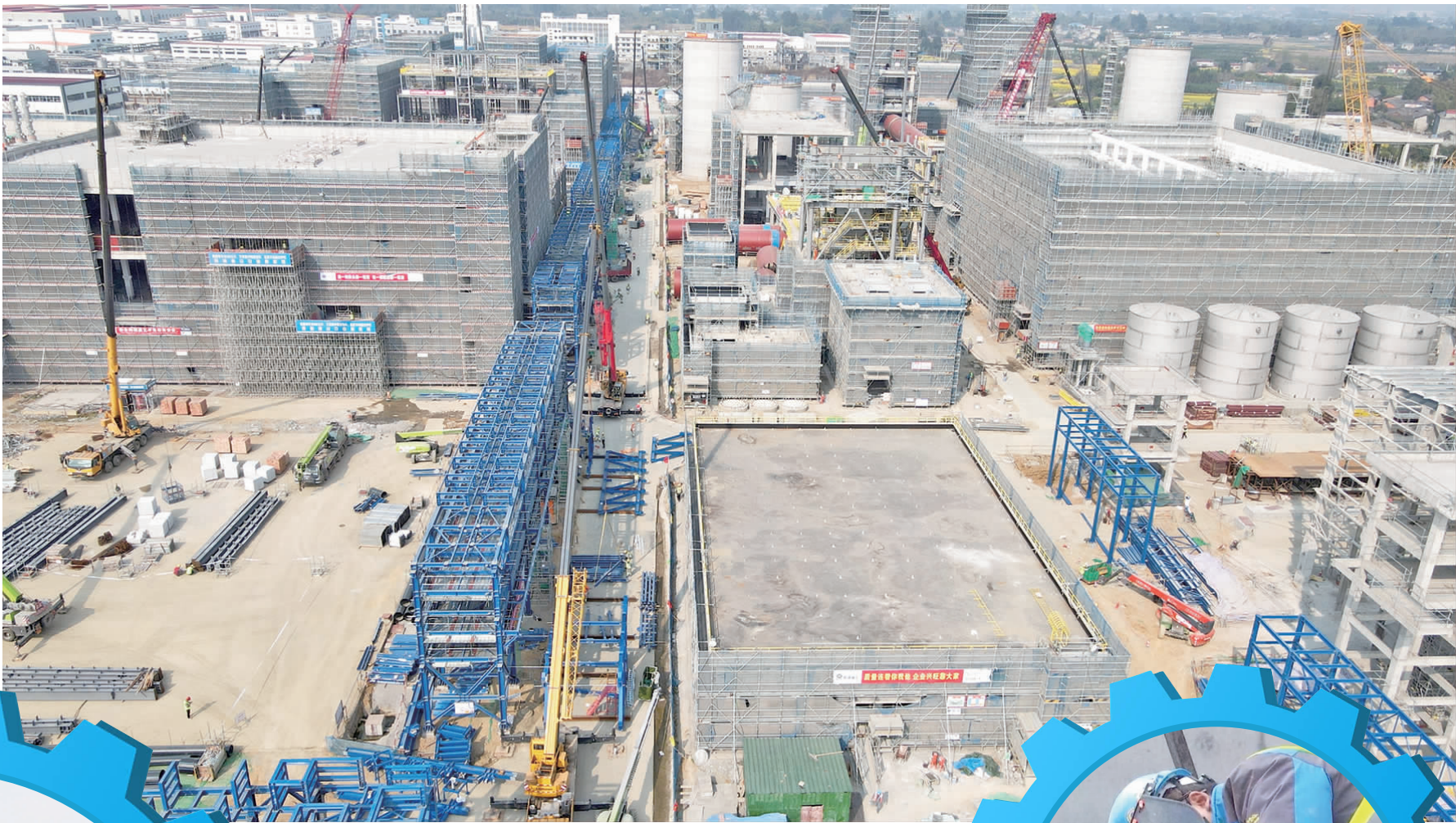
工人们铆足干劲，抓紧建设。
