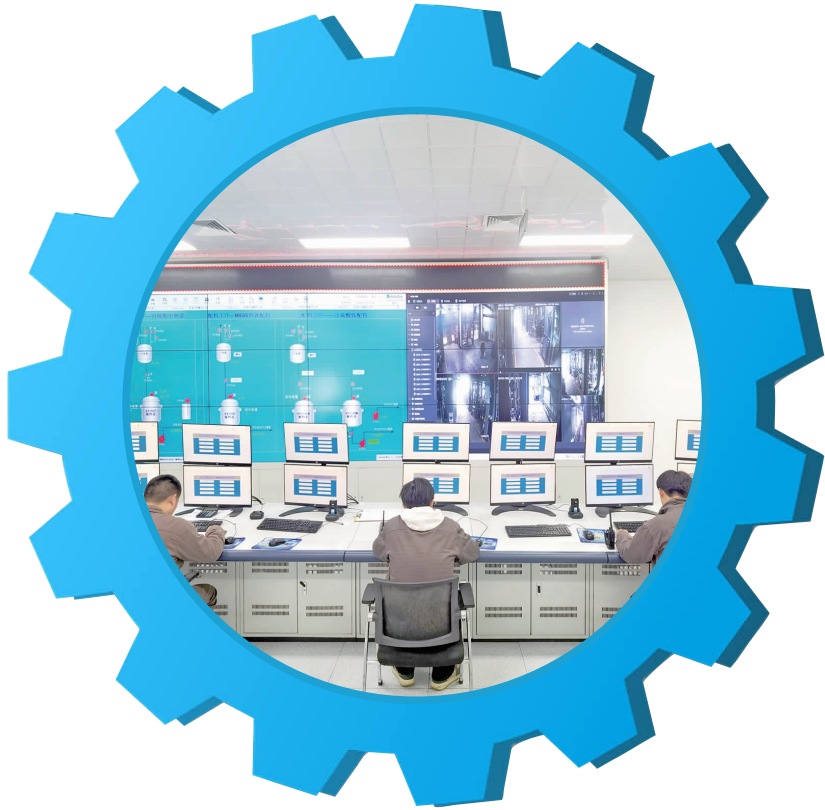
眉山茵地乐科技有限公司中控室，技术人员通过智能管控平台监测生产工序。
