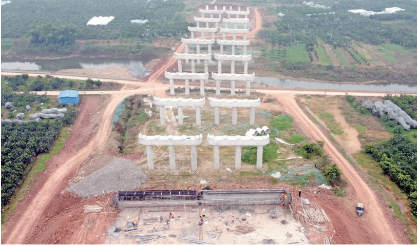
建设中的丹棱南环线项目。
