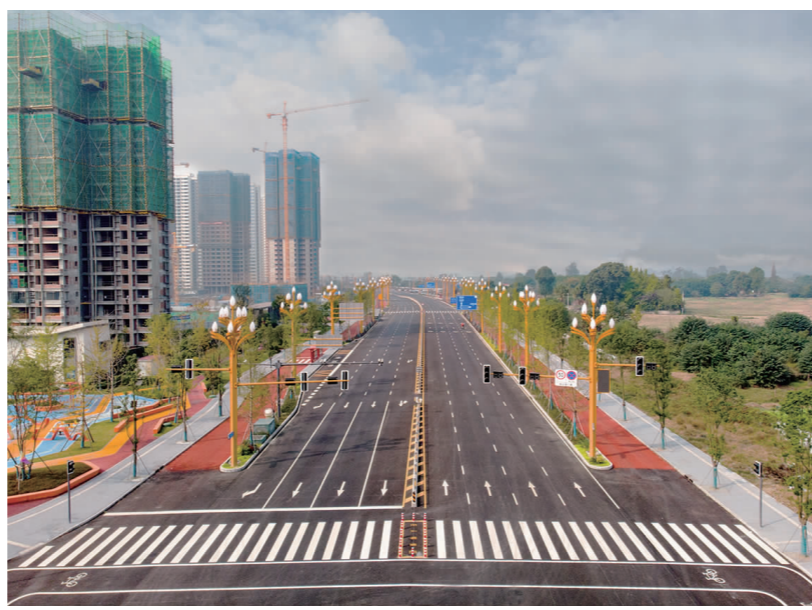
科二路地面道路建设。
