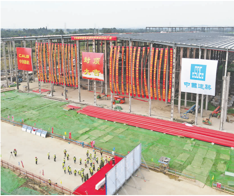
中创新航锂电正极材料项目2号主厂房顺利封顶。
