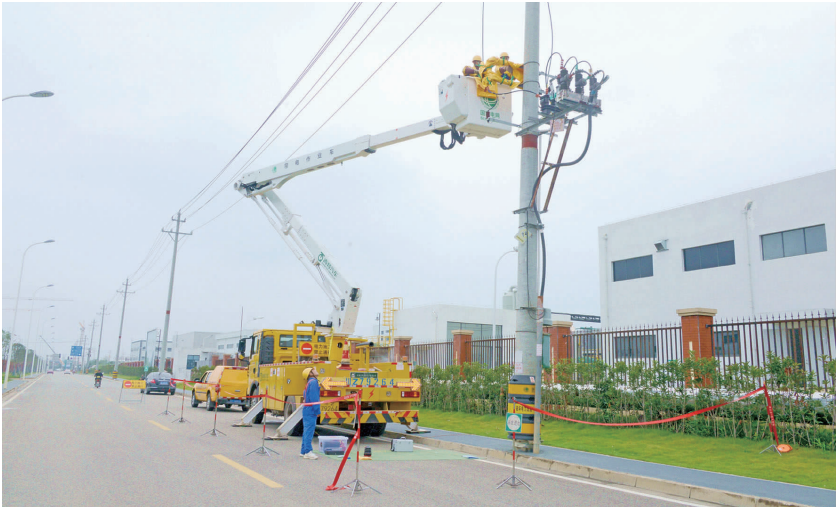
电力工人一线开展秋检工作。
