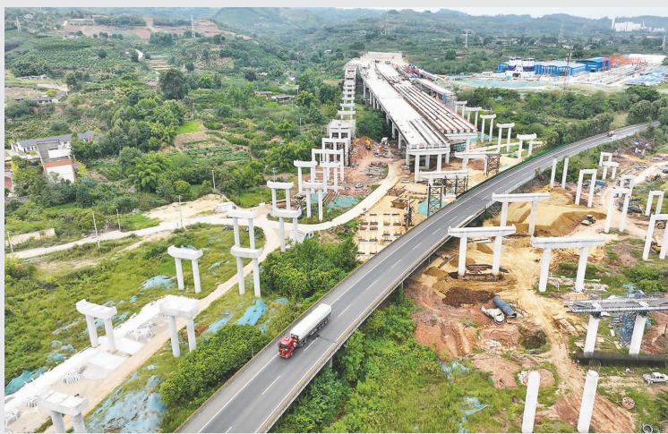
鸟瞰建设中的成乐高速公路扩容建设项目眉山三期工程青龙场枢纽。
