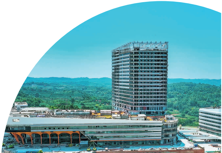
西南医科大学附属天府医院项目建设现场。
