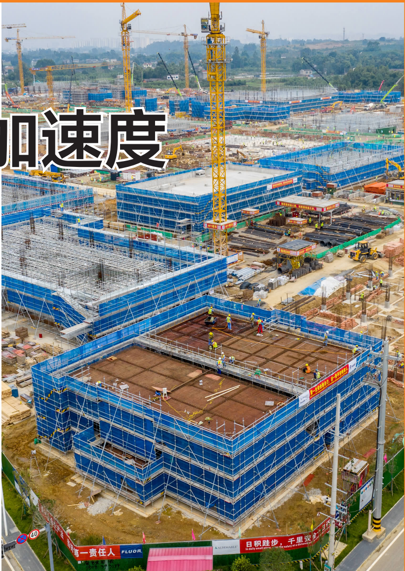
锂电项目建设正酣。 翁光建 摄
