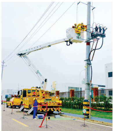
开展带电更换隐患设备。
