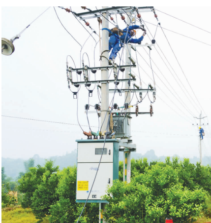
国网眉山供电公司员工在顺正5社进行农网改造。
